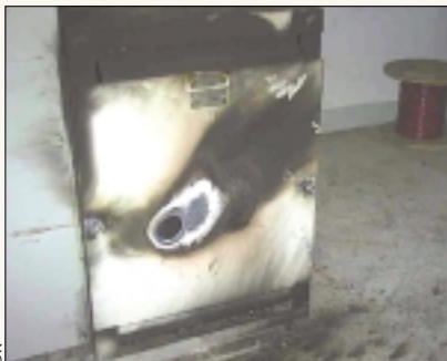
Les micro-amorçages générés par les effets corona engendrent des détériorations sur les isolants, de sérieuses avaries, des arrêts de production et parfois des morts.
